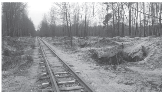
Рис. 3.11. Залізнична колія, зруйнована копачами біля смт Володимирець Рівненської області [16]
